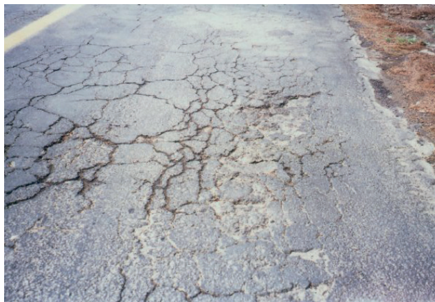
Fig. 2.36 Chaussée rigide dégradée avec amorce de nid de poule et présentant des obstacles aléatoires.
