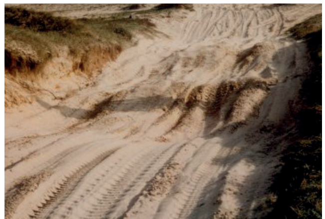
Fig. 2.35 Exemple d'ondulations sur chaussée souple (sable).
