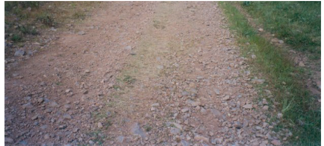
Fig. 2.20 Chaussée non revêtue, renforcée par un apport de cailloux.
