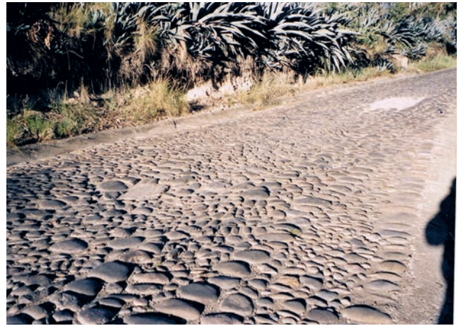
Fig. 2.33 Route pavée, constituée de grosses pierres de rivière. La surface est totalement aléatoire.
